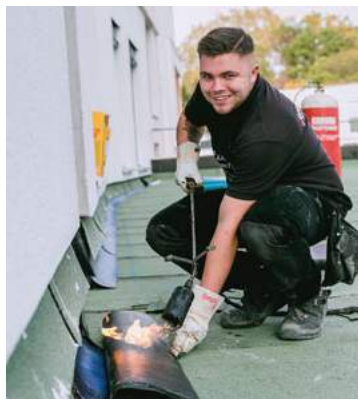
Wenn ich mit diesem Dach fertig bin, ist es absolut wasserdicht!
