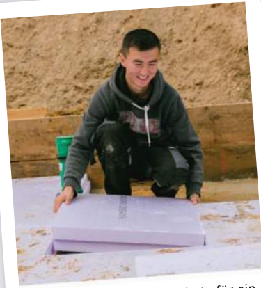
Heute habe ich die Bodenplatte für ein großes Einfamilienhaus gedämmt.
