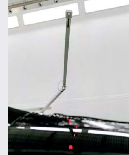
Topinnovativ und in Mönchengladbach nur bei Reiner und Christian Brenner zu finden: das Duo aus Multi-Air® Abluftsystem und Red-Eye® System zur Trocknung nach Objekttemperatur von WOLF für flexibles und effizientes Lackieren.
